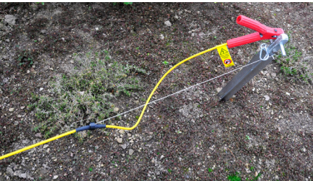
Erdung mit einem Erdungspieß
