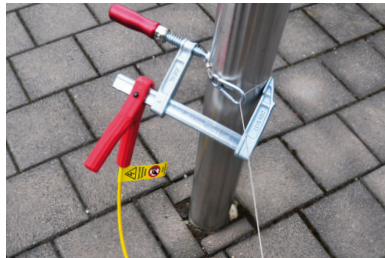
Erdung am Mast mit Hilfe einer Schraubzwinde
